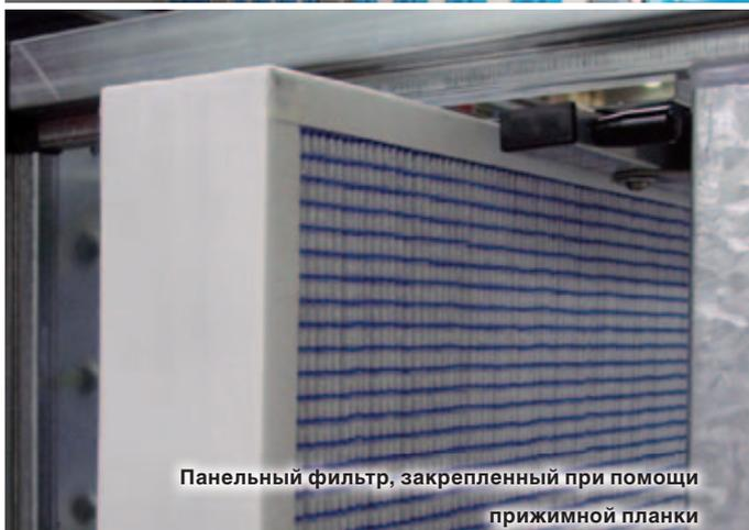
Панельный фильтр, закрепленный при помощи прижимной планки
