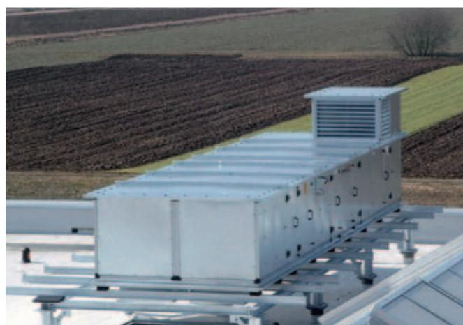
Корпус климатической установки в наружном исполнении, также как и корпус любой другой установки, можно изготовить из любых ранее перечисленных материалов. Для предупреждения коррозии мы рекомендуем для установок серий Airbox F40/S40/S60/I60 выбирать, как минимум, порошковое покрытие каркаса и внешних стенок панелей корпуса.
