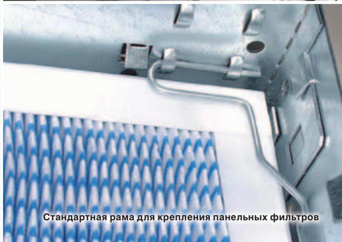
Стандартная рама для крепления панельных фильтров
