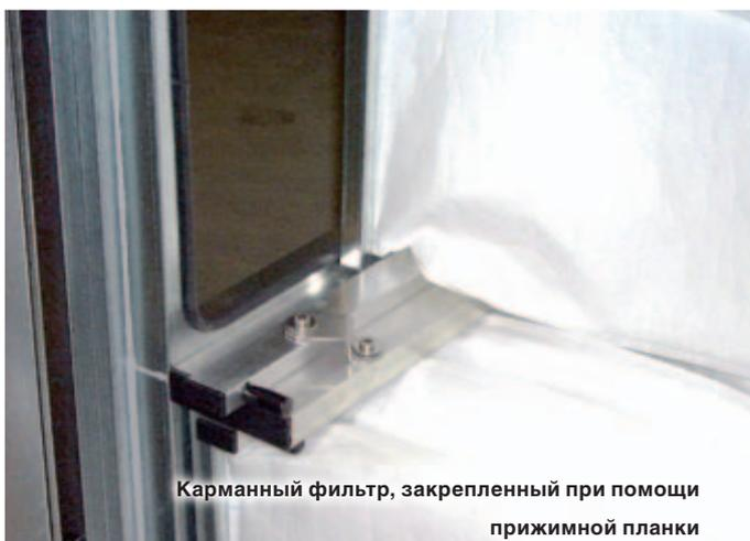
Карманный фильтр, закрепленный при помощи прижимной планки
