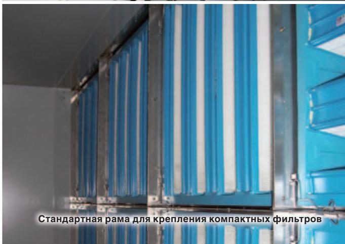
Стандартная рама для крепления компактных фильтров
