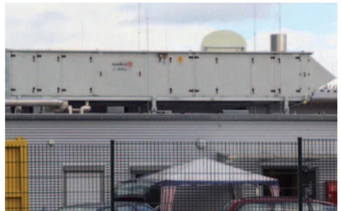
Для наружных климатических установок мы изготавливаем специальные принадлежности. Чтобы предотвратить попадание осадков внутрь вентиляционных отверстий на входе и выходе воздуха из установки, мы предлагаем специальные защитные козырьки или решетки. Каплеуловитель, устанавливаемый в секции приема наружного воздуха, дополнительно защищает установку от попадания влаги.
